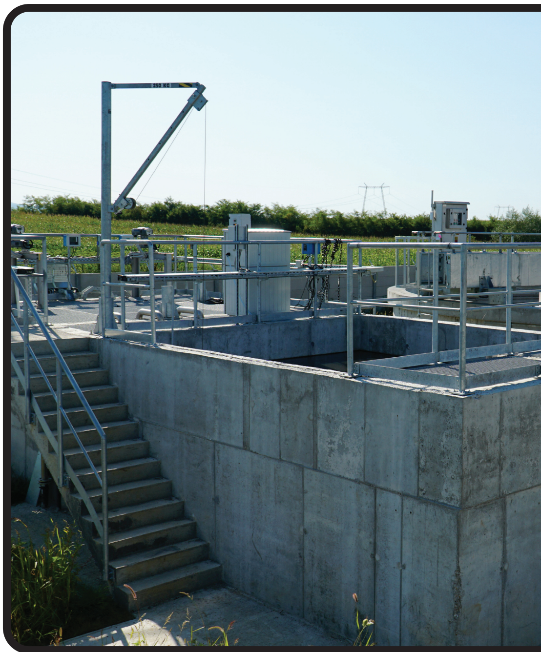
Contract POIM-SM-CL-13: Stația de epurare a apelor uzate Medieșu Aurit
