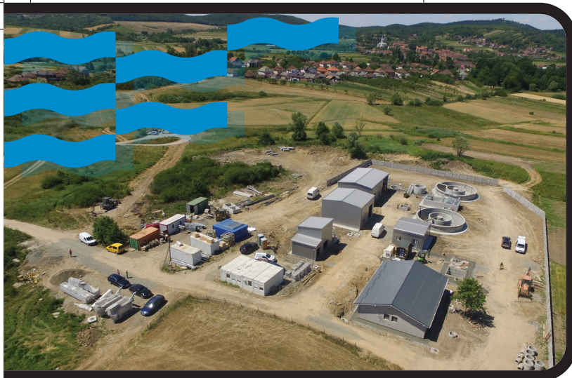
Contract POIM-SM-CL-12: Stația de epurare a apelor uzate Orașu Nou
